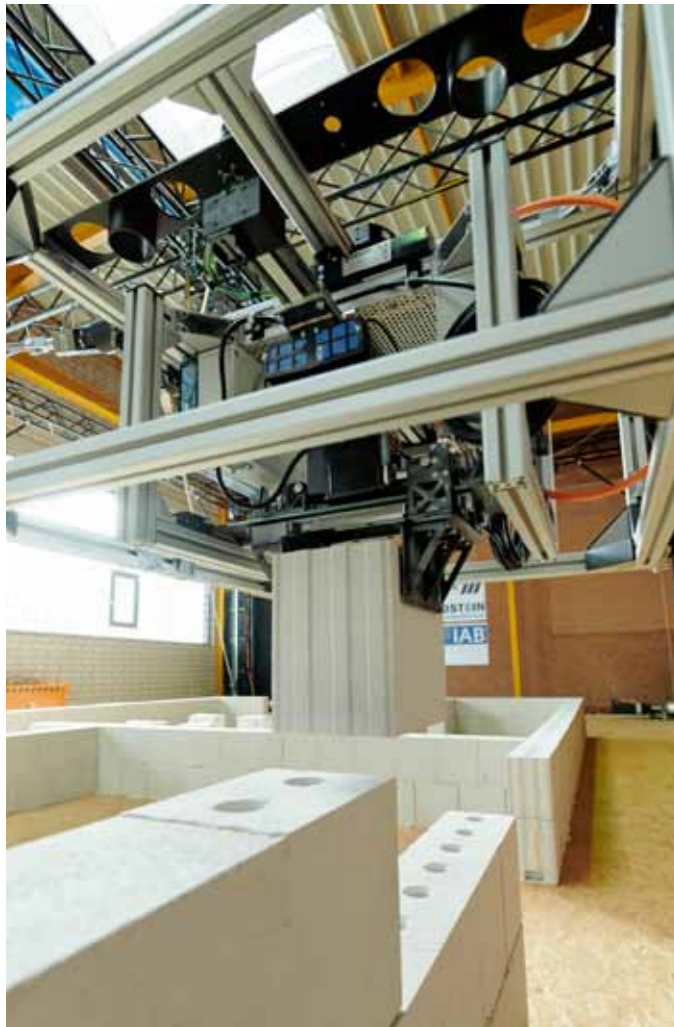
So könnte das Mauern von morgen aussehen: Ein handelsüblicher Kalksandstein (23 Kilogramm) wird zunächst maschinell bemörtelt, dann vom Seilroboter zur richtigen Stelle transportiert, platziert (Bild) und – wenn es sein muss – auch versetzt. Das funktioniert über mehrere Etagen.
