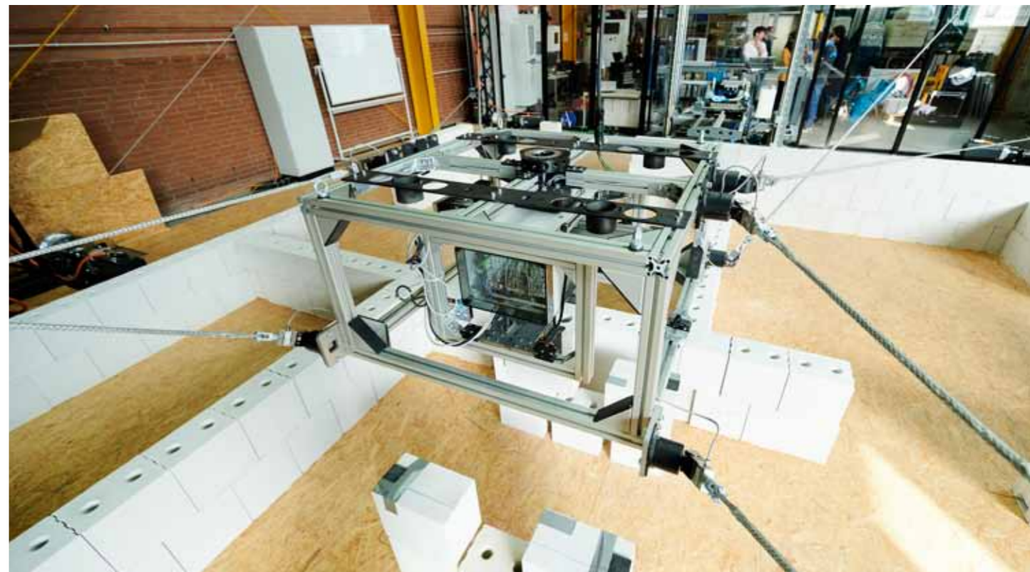
Blick von oben: Der Seilroboter hat die ersten Mauerreihen geschafft.
