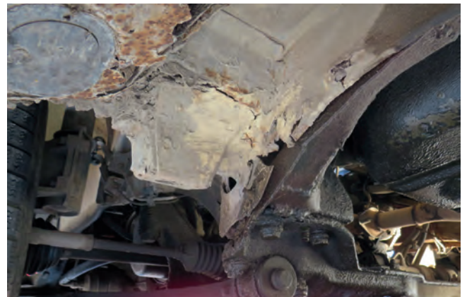
Unsachgemäße Reparatur im Bereich des Längsträgers
