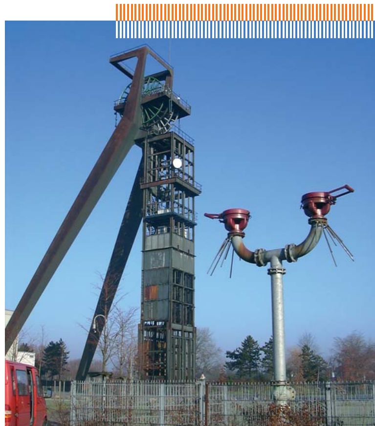
Schacht Recklinghausen II mit Protegohaube im Vordergrund
