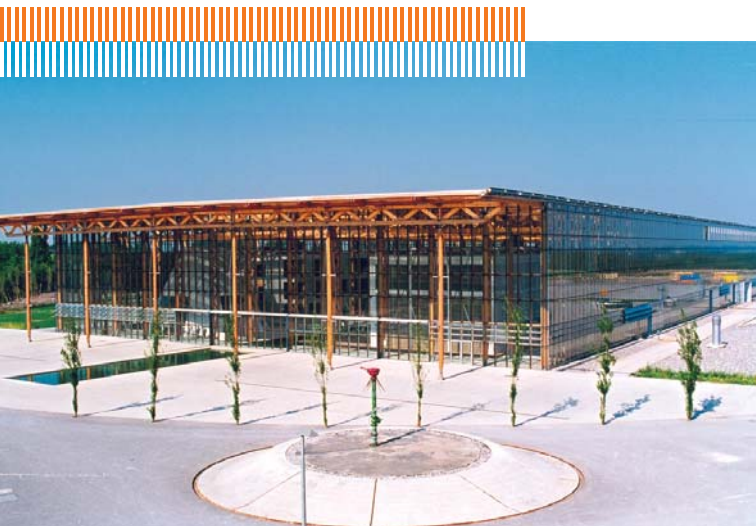
Keine "Kunst am Bau", sondern: Abschluss Schacht Mont-Cenis 1 mit Protegahaube vor der Fortbildungsakademie Mont-Cenis
