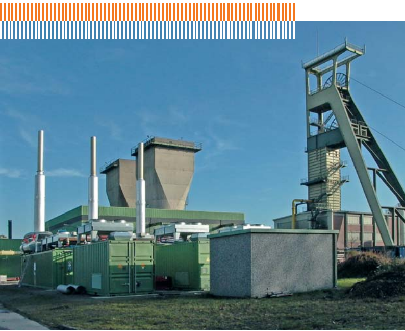
Grubengasverwertungsanlage auf der Schachtanlage Prosper IV, Schacht 9, in Bottrop-Grafenwald Foto: Evonik Steag GmbH
