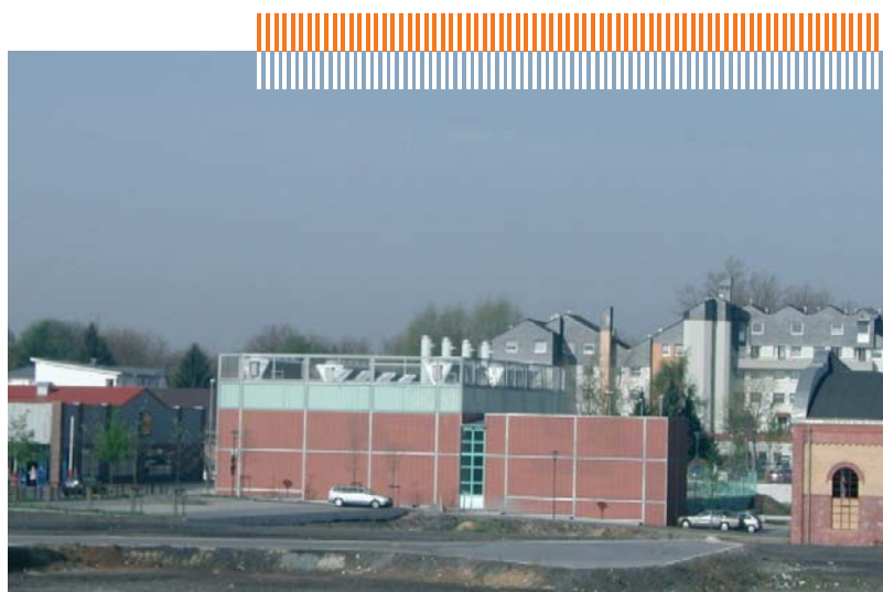
EnD-I Grubengaskraftwerk auf dem ehemaligen Bergwerk Lothringen in Bochum-Gerthe
