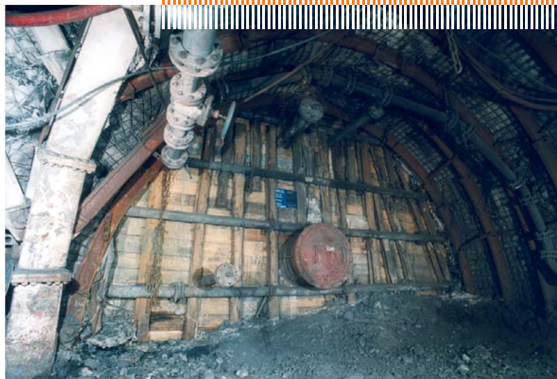
Abgeworfener und mit einem Abschlussdamm versehener Grubenbau, vorbereitet mit Anschluss zur Gasabsaugung
