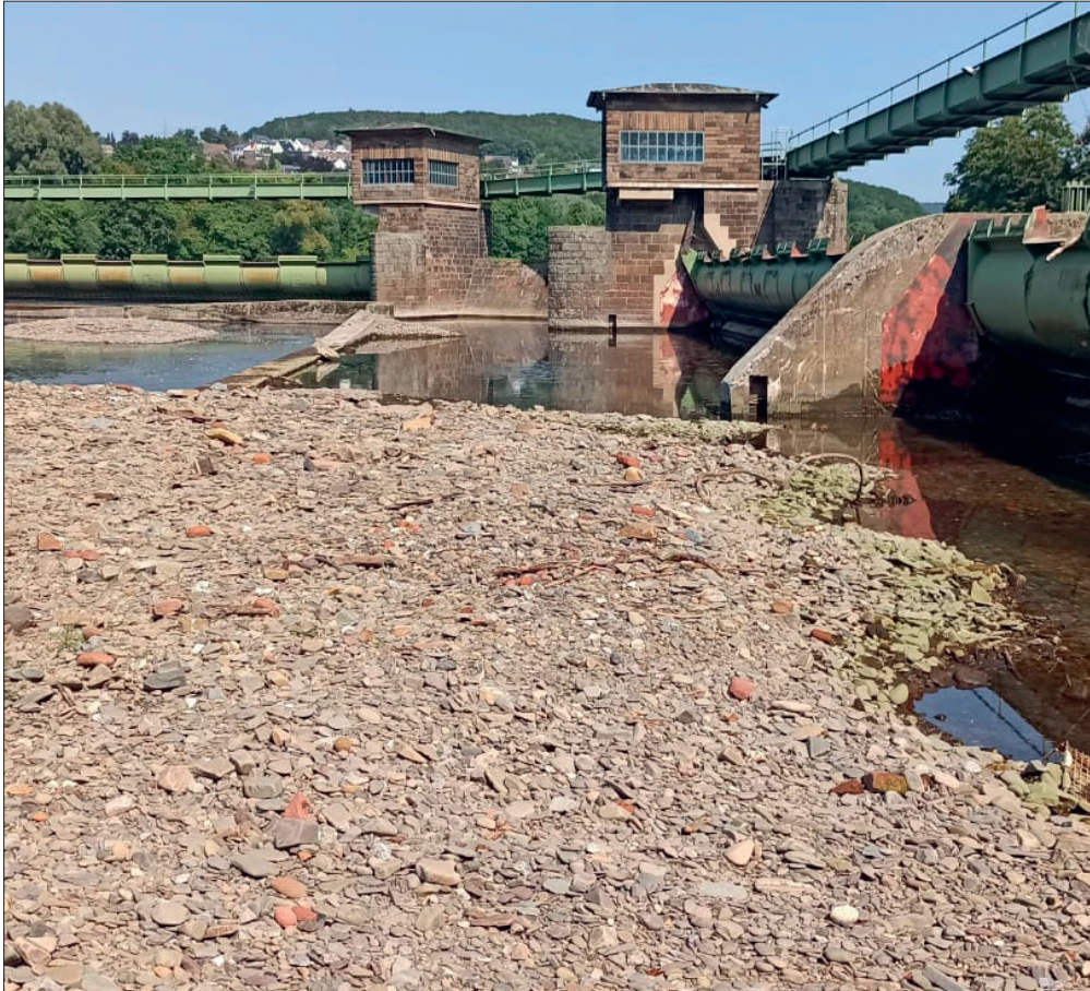
Bild 8.5: Sedimentsituation nach dem Hochwasser im Juli 2021 an der Wehranlage Stiftsmühle Fig. 8.5: Sediment situation after the floods in July 2021 at the weir Stiftsmühle
