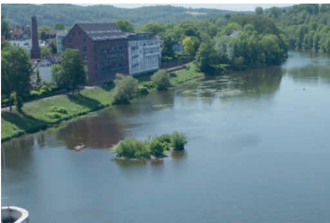
Bild 8.3: Sedimentablagerungen unterhalb der Wehranlage Baldeneysee im Jahr 2020 Fig. 8.3: Sedimentation downstream of the Lake Baldeney weir in 2020
