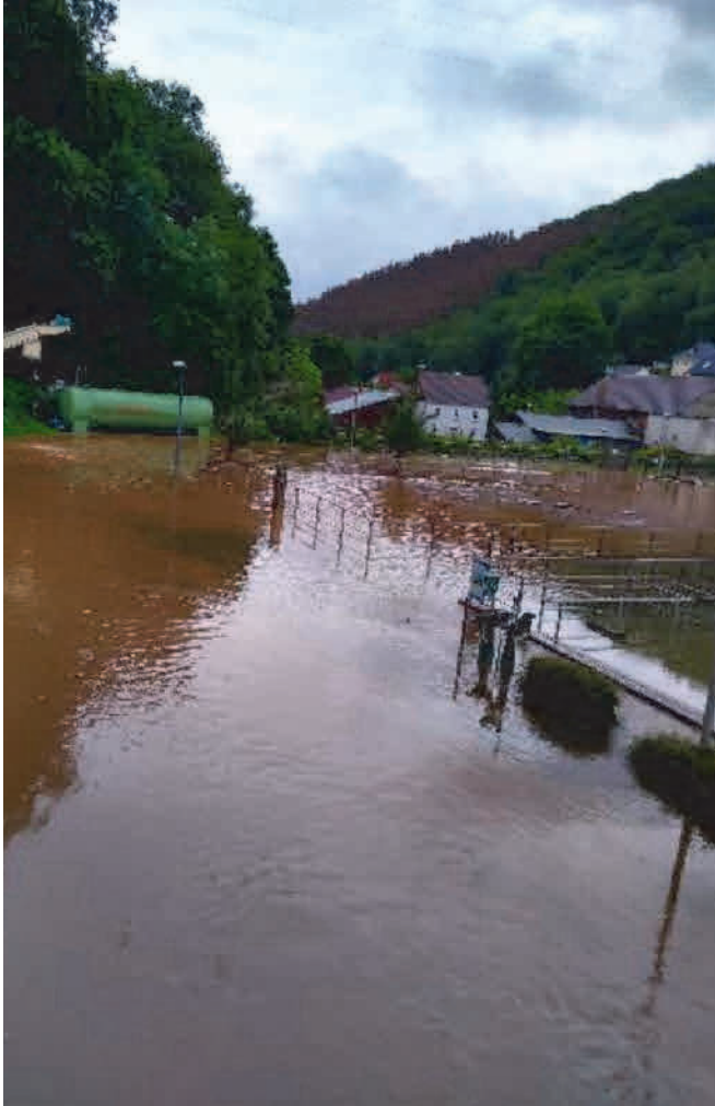
Bild 8.9: Kläranlage Rahmedetal, Überflutung Nachklärbecken/Regenüberlaufbecken am 14.07.2021 gegen 17.30 Uhr Fig. 8.9: Rahmedetal sewage treatment plant, flooding of the secondary sedimentation tank/detention basin on July 14, 2021 at 5:30 p.m.
