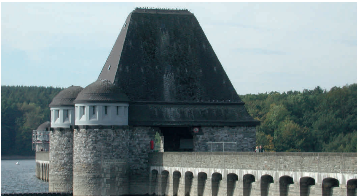
Bild 6.3: Möhnetalsperre, Blick auf die Mauer Fig. 6.3: Möhne Reservoir, view at the dam
