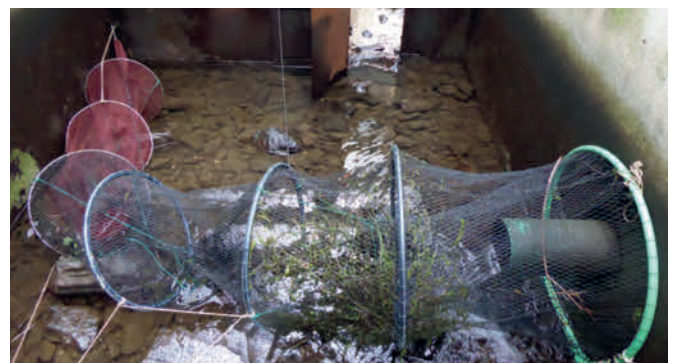
Bild 18.12: Reuse am Auslauf des Aalfluchtrohrs Fig. 18.12: Fish trap at the outlet of the escape pipe for eels
