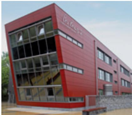
Der Bau überzeugt durch eine besonders gute Wärmedämmung und eine mechanische Lüftungsanlage, die über einen Wärmetauscher die Wärmeenergie der Abluft auf die angesaugte Außenluft überträgt. Das Gebäude der Lore-Lorentz-Schule weist einen besonders niedrigen Heizwärmebedarf von nur ca. 15 kWh/m<sup>2</sup> pro Jahr auf.
