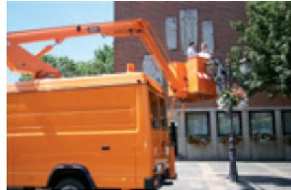
dieses vorzeigbare Ergebnis zu erreichen, war es zudem erforderlich eine Instandsetzung des Beleuchtungsnetzes durchzuführen. Die rein energetischen Sanierungsmaßnahmen betrafen 864 von 1.090 Leuchten sowie 18 Schaltschränke, in denen 26 Spartransformatoren eingebaut wurden. Die Gesamtkosten für alle Maßnahmen betragen rund 479.500 Euro und wurden vom Bundesumweltministerium mit über 75.000 Euro bezuschusst.
