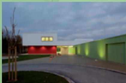
Die Gebäudekonstruktion basiert auf einer hochwärmegedämmten Holzständerbauweise. Berechneter Heizwärmebedarf: 13,4 kWh pro Quadratmeter und Jahr. Für Wärme und Kühlung sorgt eine Wärmepumpe, die Außenluft über ein Erdreichsondenfeld vortemperiert. Die Lüftungsanlage ist mit einer Wärmerückgewinnung gekoppelt. Und für Warmwasser sorgt eine solarthermische Anlage. Der Strombedarf wird über eine dachinte-
