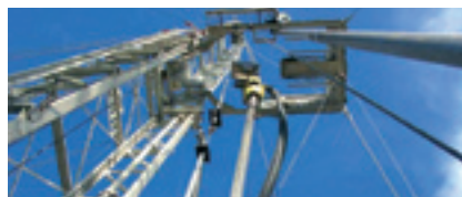
Bohren nach Erdwärme
