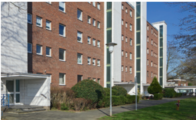
Carlo-Mierendorff-Straße 22-25, Neuss, vor der Sanierung
