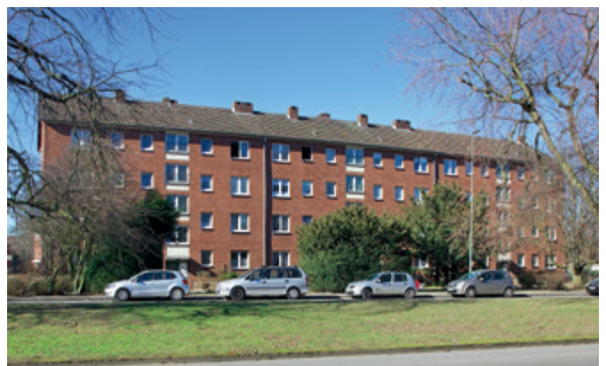
Römerstraße 91-95, Neuss, vor der Sanierung
