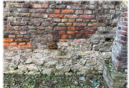
Notwendige Fundamentierung der Stützmauer
