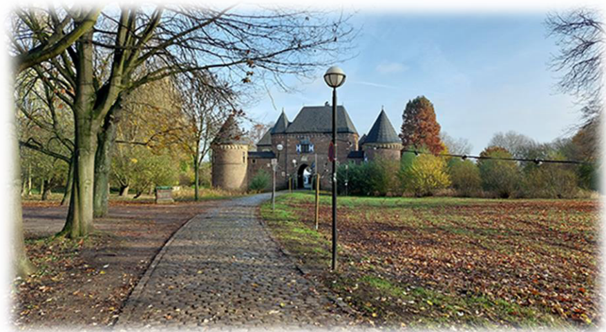
Das Foto zeigt den jetzigen Zustand der Wegebeleuchtung vor dem Torhaus, das Titelbild die geplanten Veränderungen.
