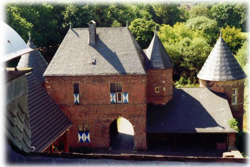
Blick auf das Torhaus mit Obergeschoss vom Burghof aus
