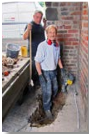
Tor auf sicherem Fundament
