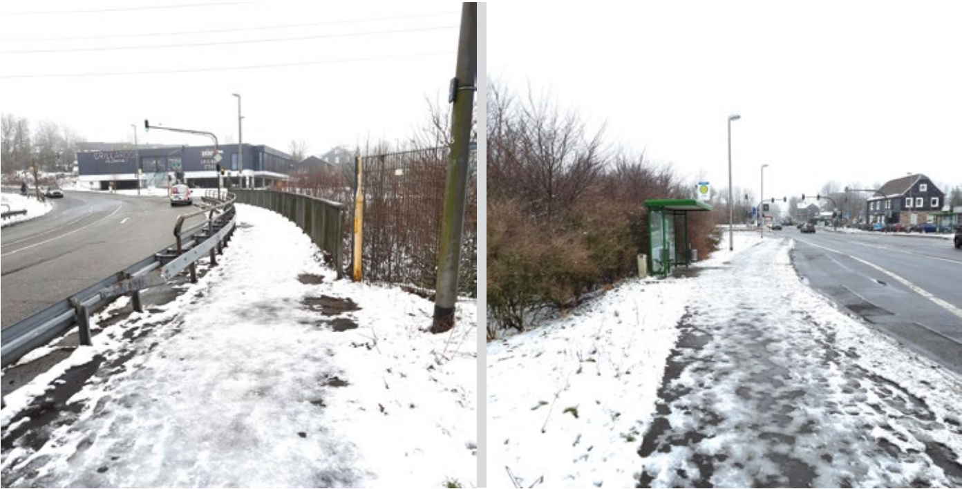
Dicke Eispolster bilden sich vor der Bushaltestelle (Foto r.) und auf dem Fußweg über die Eisenbahnbrücke. Hier wird weder geräumt noch gestreut.
