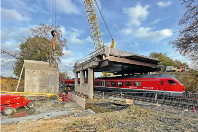
Die in Fertigbauweise vorproduzierten Flügelwände wurden schnell und präzise aufgestellt
