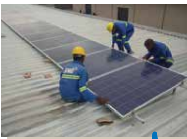
Januar 2021, MALAWI: Zur Fertigstellung des neuen Standortes in Blantyre gehört auch die Installation einer Solaranlage auf dem Dach.
