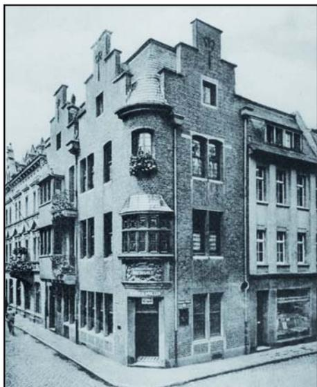
Oben: Dieses Foto, das noch vor 1920 entstanden sein muss, weil über dem Eingang noch „Gastwirtschaft Heinrich Müller“ steht, zeigt deutlich, dass der Neubau, der 1911 errichtet wurde, erheblich von dem Plan von 1907 abweicht, z. B. erkennbar an den Balkonen und den Treppengebeln.
