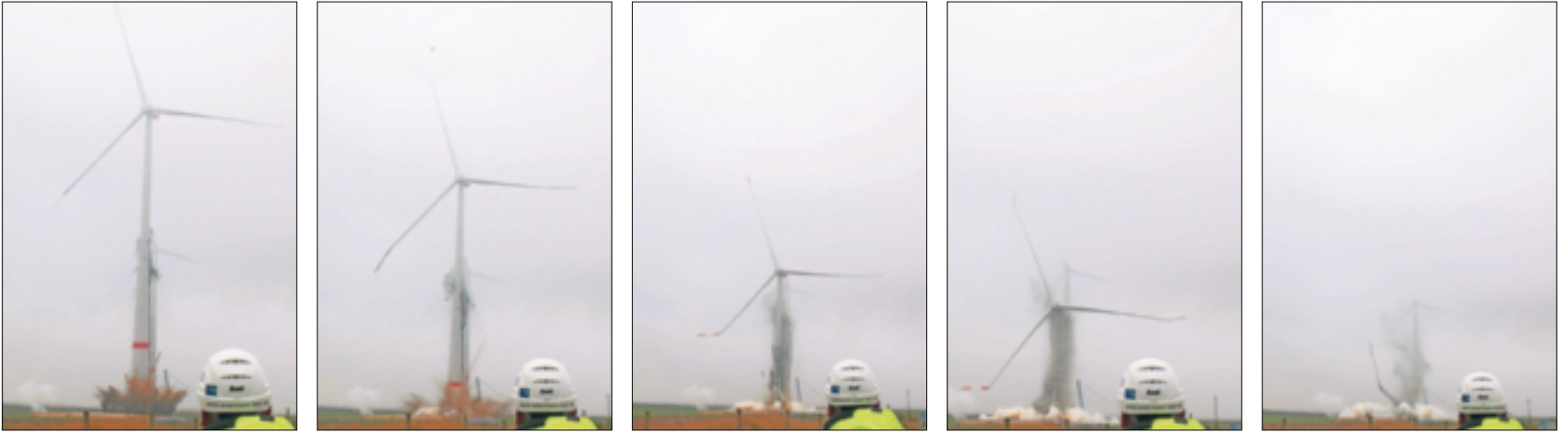
Das Windkraftrad sackt zusammen und fällt dann wie geplant in das vorbereitete Bett aus Sand und Kies. Die großen Rotorblätter biegen und brechen. Der Schrott muss nun geborgen und entsorgt werden. Immerhin geht es auch um giftige Stoffe. Mehr dazu im unten stehenden Bericht.
