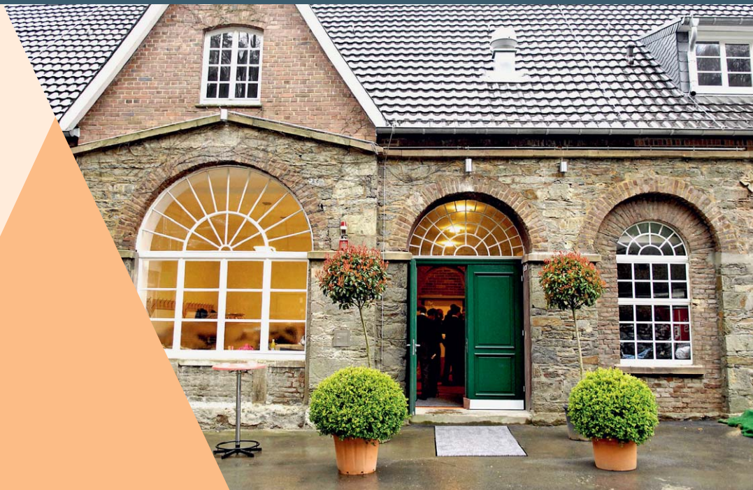
© Alte Schlossfabrik, Solingen
