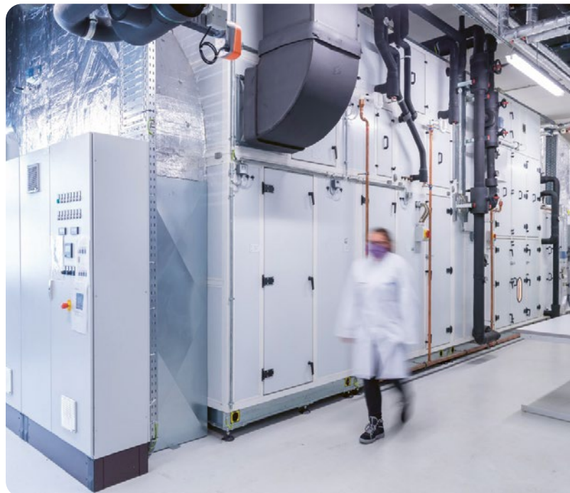
Am MEET Münster forschen Wissenschaftlerinnen und Wissenschaftler an der Batterie der Zukunft.
