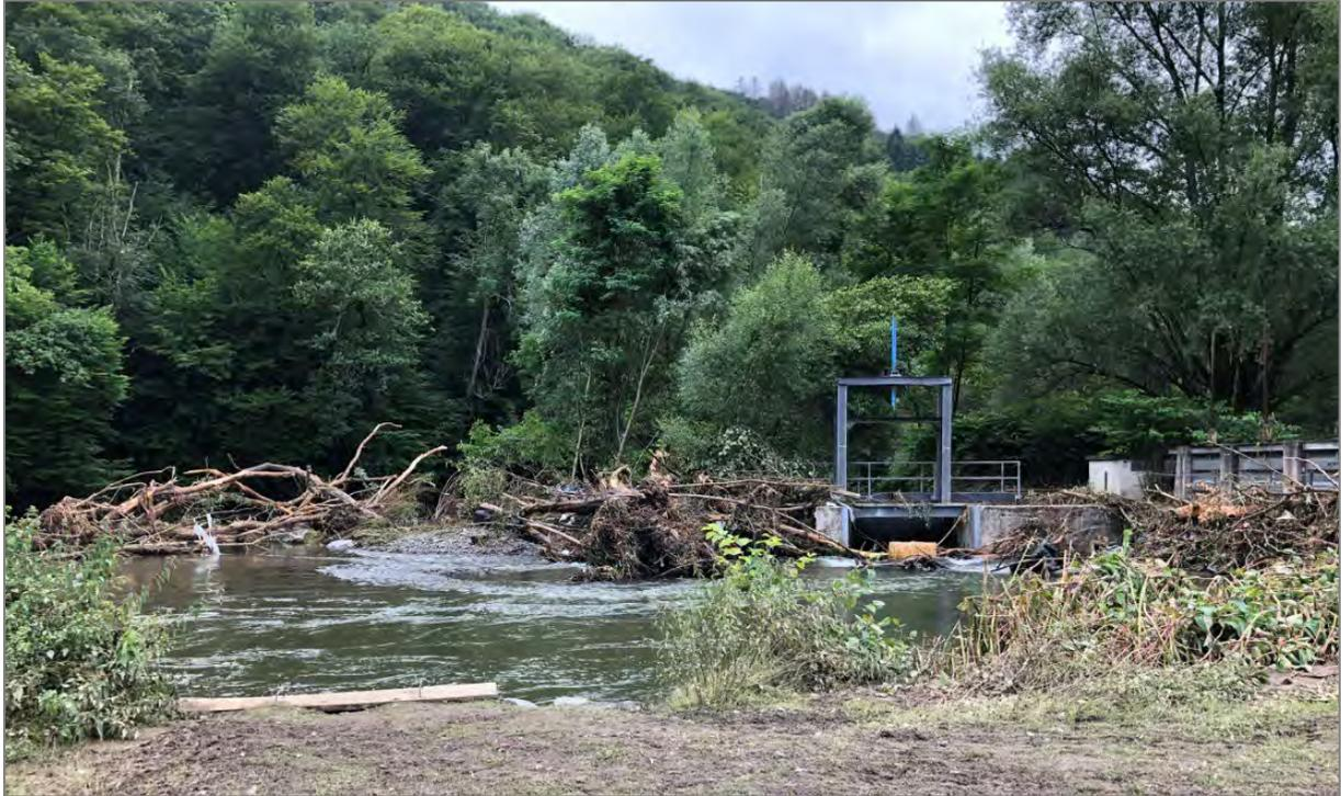
**Abb. 1: Von mitgerissenen Bäumen und Wohnwagenteilen blockierte Wehranlage am Auer Kotten innerhalb des FFH-Gebietes „Wupper von Leverkusen bis Solingen“ (Foto: 19.07.2021, Jan Boomers)**
