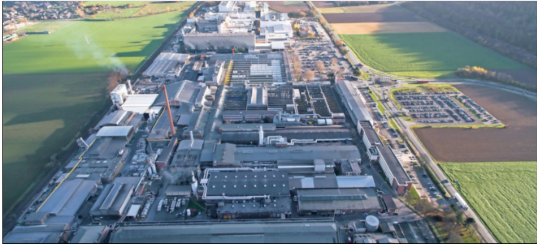
An der Aluminiumstraße wurde Anfang des vorigen Jahrhunderts quasi der Grundstein für das „Industriegebiet-Ost“ gelegt, das sich im Laufe der Jahre erfolgreich weiterentwickelte. Hier ist der Blick weit nach Süden gerichtet. Foto: Hydro
