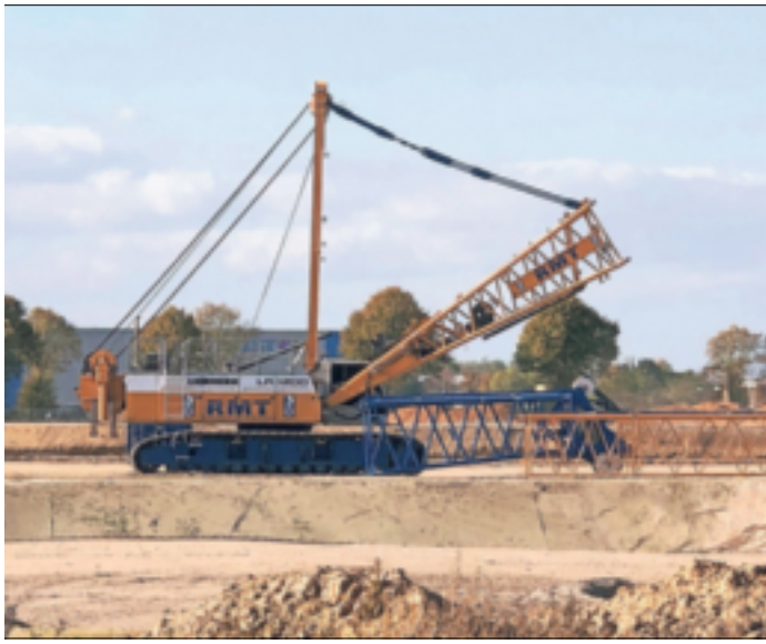
Unübersehbar: Die „Lidl“-Baustelle für das neue Logistikzentrum.
