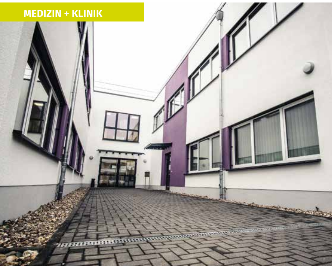
Für SAM wurde das Gebäude des SGN um eine Etage erweitert.
