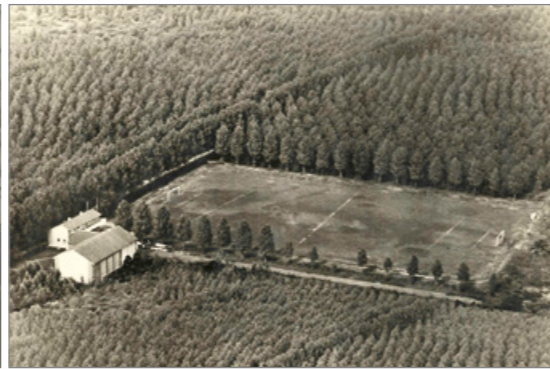
Bendsportplatz mit alter Halle um 1962
