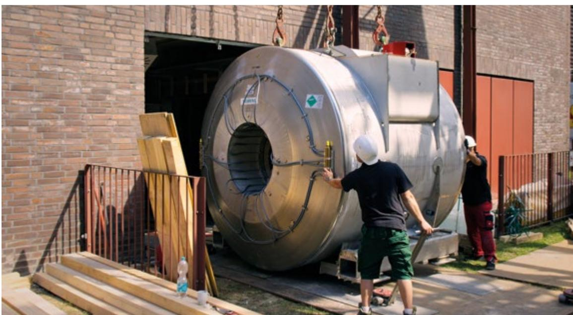
Einbringung des 7-Teslamagneten in das ELH
