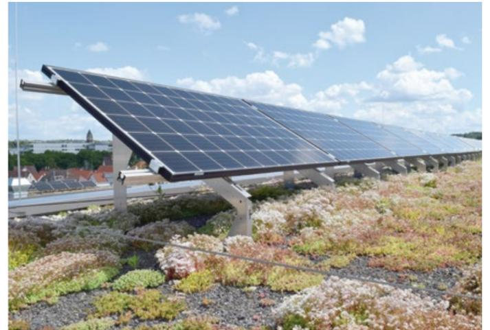
zur Stromerzeugung nutzen. Dabei hilft die kühlende Wirkung der Begrünung auch an sehr heißen Tagen die Effizienz der Solarpaneele zu erhalten. Deren Leistung lässt nämlich mit zunehmenden Temperaturen nach.
