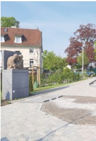
Vor dem „Badepärchen“ wird ein Wasserspiel installiert.
