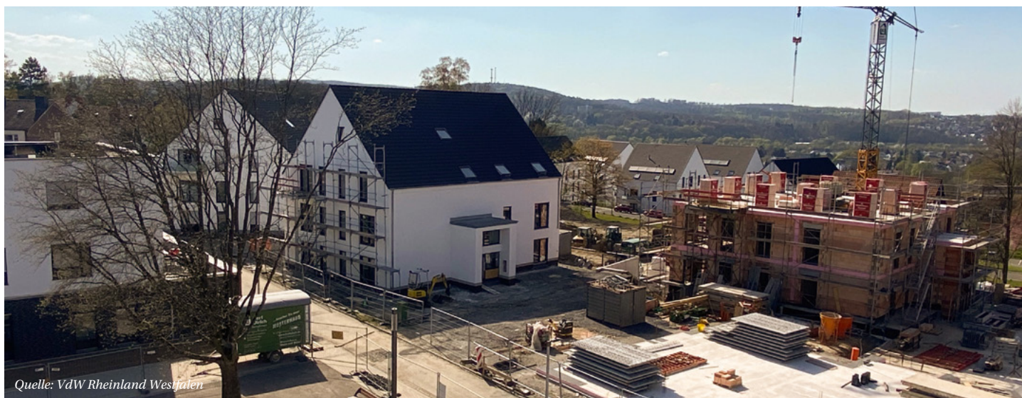
Die ersten Wohnungen sind fertiggestellt, in den nächsten Bauabschnitten wird das zukunftsweisende Wohnquartier der AWG im nächsten Jahr komplettiert und bezahlbaren und klimaschonenden Wohnraum bereitstellen
