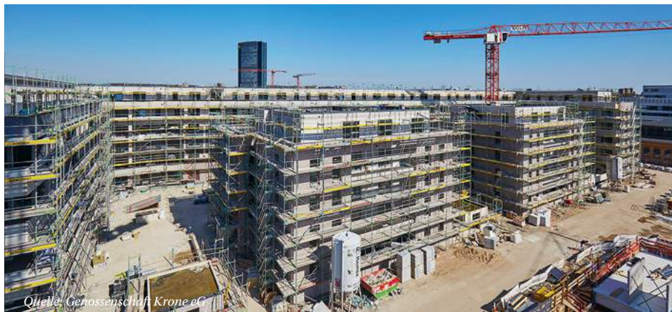
Bau und Architektur aus einer Hand: Der gemeinsame Bau der WOGEDO, DWG und BWB befindet sich mitten in der Umsetzung
