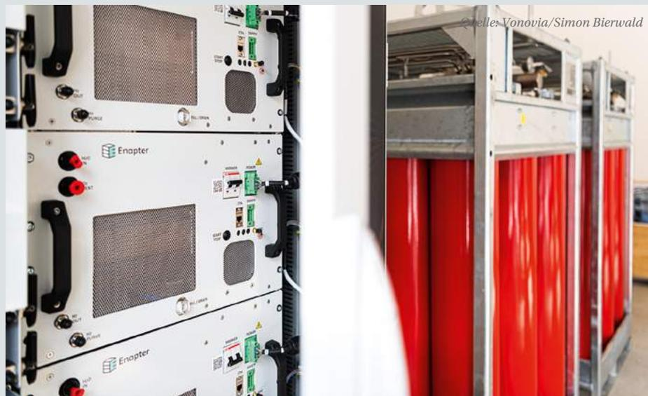
Durch elektrische Spannung wird der in den roten Behältern gelagerte Wasserstoff zu nutzbarer und klimaeffizienter Energie
