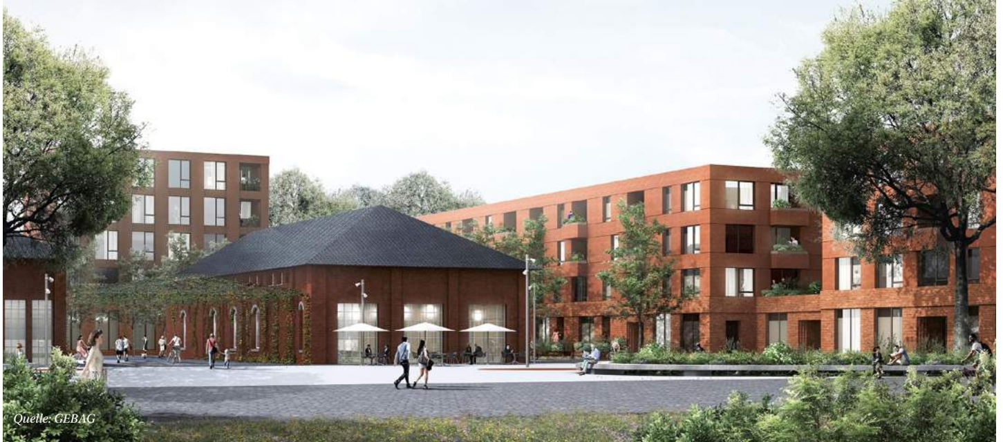
Die für das Wohnquartier charakteristischen Hallensegmente zwischen den Wohngebäuden bleiben erhalten und stellen die architektonische Qualitäten des Theisen-Geländes in Duisburg-Hochfeld sicher
