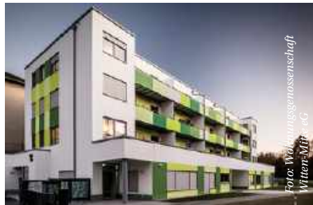
Modern mit 125 Jahren: Der Neubau der Witten-Mitte eG in Witten-Bommern bietet eine Kindertagesstätte und Wohnen unter einem Dach
