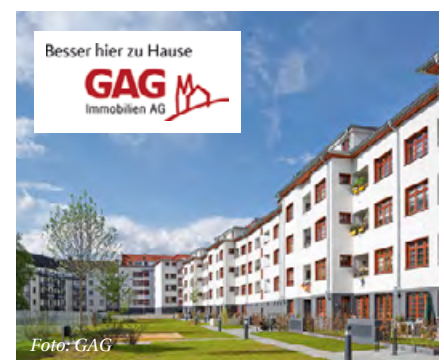
Die umfassend modernisierte Naumannsiedlung erstrahlt wieder im ursprünglichen Glanz
