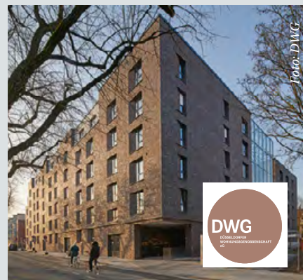
Die 70 neuen, teils öffentlich geförderten Wohneinheiten bieten 4.600 Quadratmeter Wohnfläche in Düsseldorf-Oberkassel
