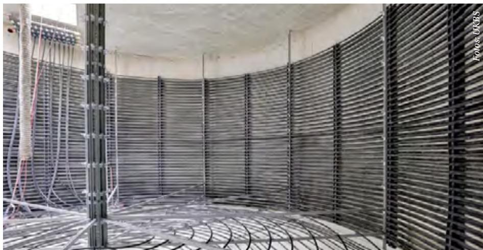
Wenn Wasser zu Eis gefriert, gibt es Energie ab. Mithilfe einer Wärmepumpe kann diese dann zum Heizen genutzt werden
