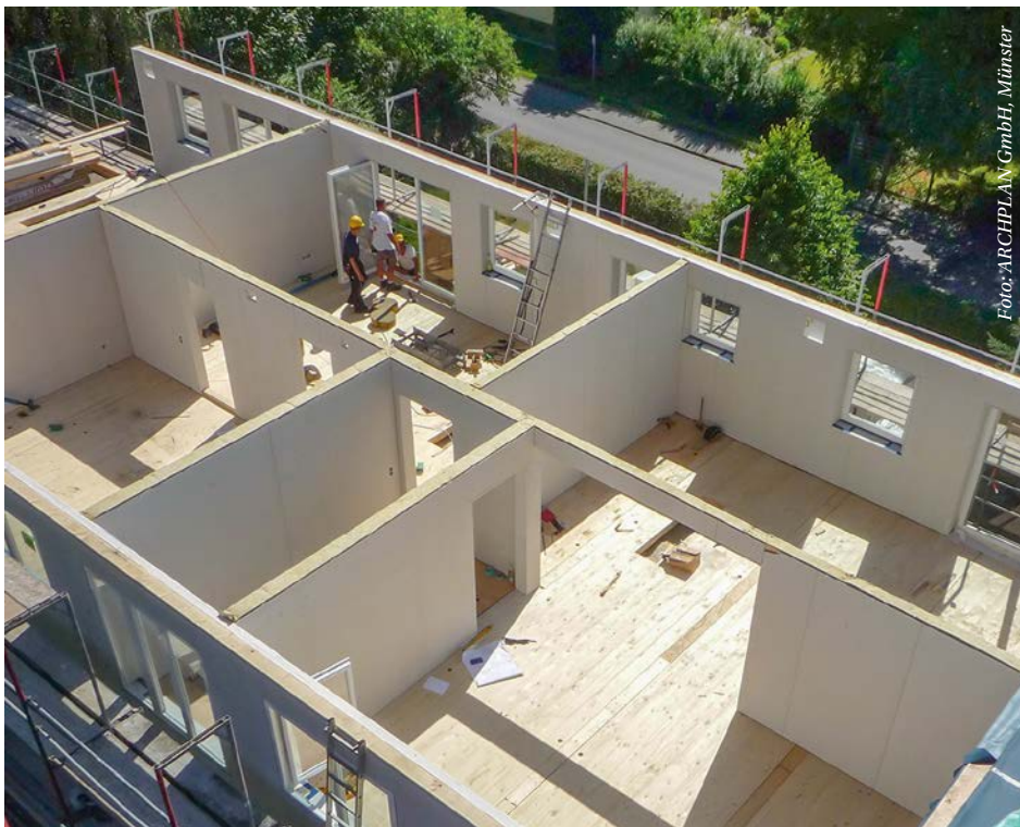
Sanierung und Aufstockung der „Ford-Siedlung“ der LEG Wohnen NRW GmbH, Köln
