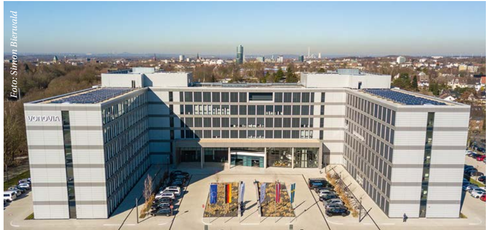
In 2016 begonnen, 18 Monate später fertiggestellt: die Vonovia-Unternehmenszentrale
