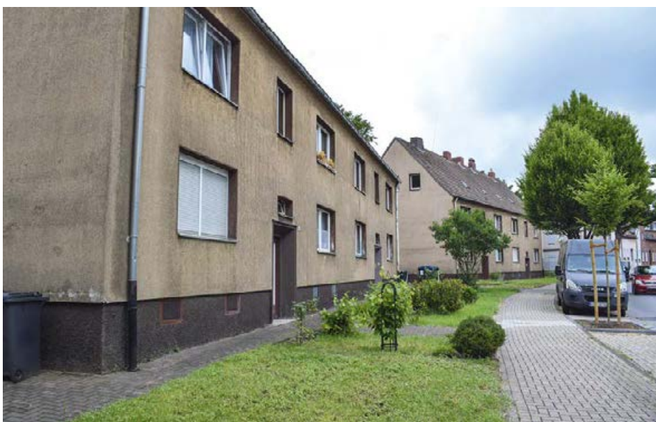
Stadt Bottrop und GBB haben zur Modernisierung der Siedlung zusammengefunden
