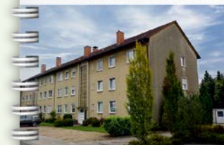
Gebäudebeispiel vor der Modernisierung
