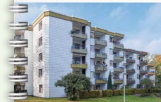
Gebäudebeispiel vor der Modernisierung
