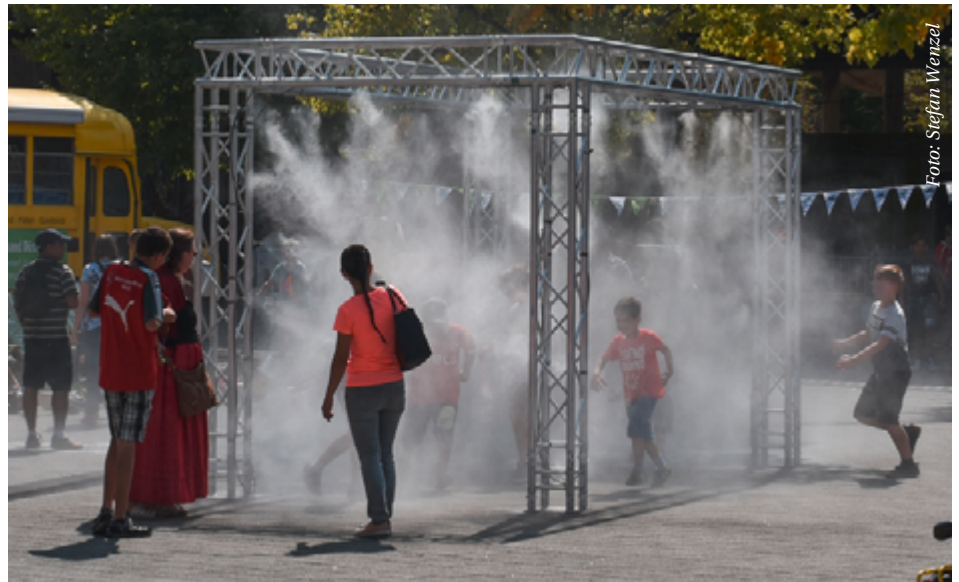
Test Brumisateur – Kühlung durch Verdunstungskälte im öffentlichen Raum
