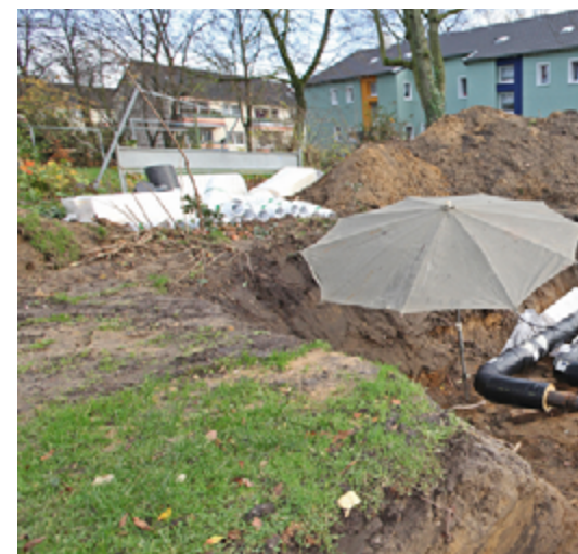
Ein Nahwärmenetz entsteht – umfangreiche
