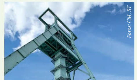
Steht für Tradition: der Fördererturm am Bergbau-Museum in Bochum
