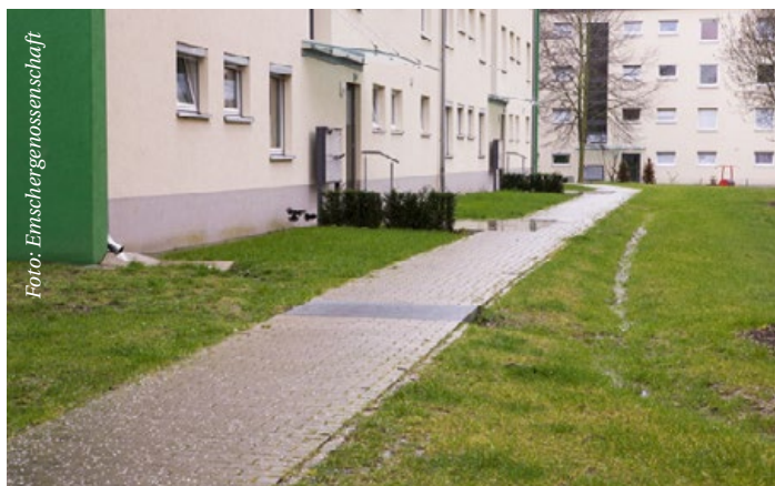
Anlagen zur offenen Ableitung von Regenwasser in die angrenzende Emscher auf dem Gelände der DOGEWO 21 in Dortmund-Mengede bei trockenem Wetter und bei stärkerem Regen
