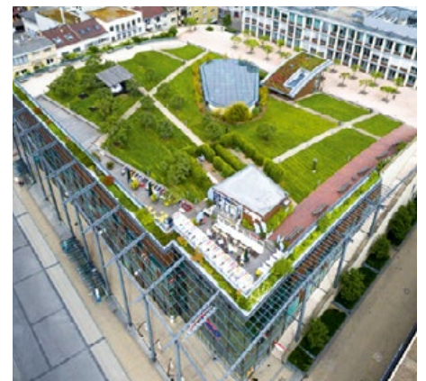
Der Blick aus der Vogelperspektive auf die Dächer im Stadtzentrum von Pforzheim zeigt, welche Dächer begrünt sind und wo noch Potenziale liegen
