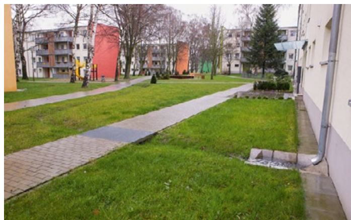
Anlagen zur offenen Ableitung von Regenwasser in die angrenzende Emscher auf dem Gelände der DOGEWO 21 in Dortmund-Mengede bei trockenem Wetter und bei stärkerem Regen
