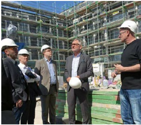
Besichtigung der Baustelle im Quartier „York-Höfe“
