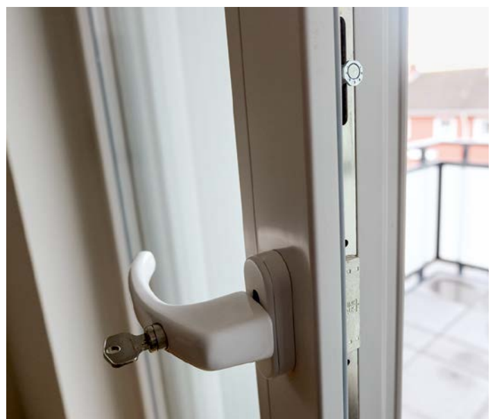
Abschließbare Fenstergriffe und Pilzkopfpapfen schützen die Fenster vor Aufhebeln.
