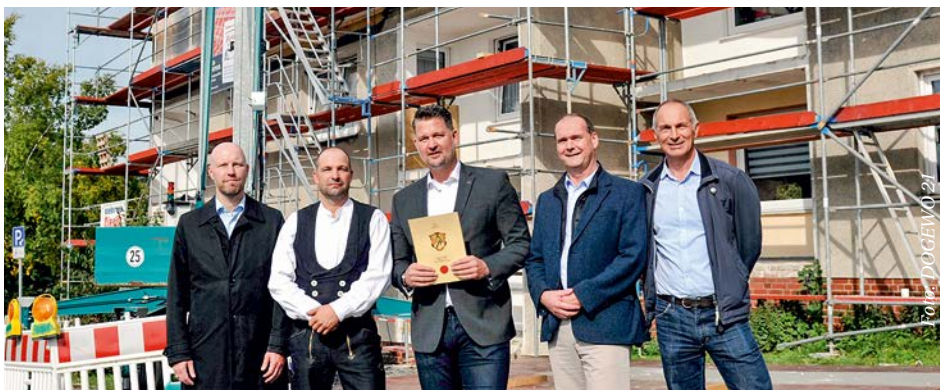
Gero Scheebaum (Bereichsleiter DOGEWO21), Detlef Heil (Zimmermann), Christian Nagel (Prokurist), Uwe Jänike (Projektleiter), Ulrich Nowak (Bauleiter DOGEWO21) (v. l.)
