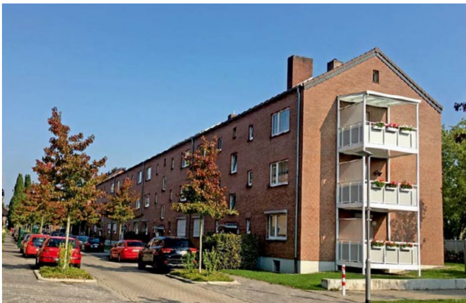
Barrierefreiheit im Wohnumfeld konnte durch das Städtebauförderprogramm Stadtumbau West in Wesel realisiert werden.
