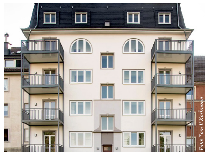
Angebaute Balkone erhöhen jetzt die Wohnqualität.
