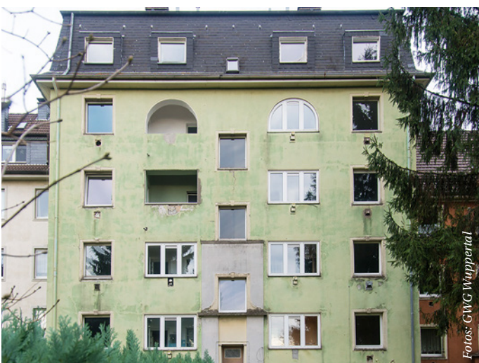
In die Jahre gekommen: die alte Rückansicht des Hauses
