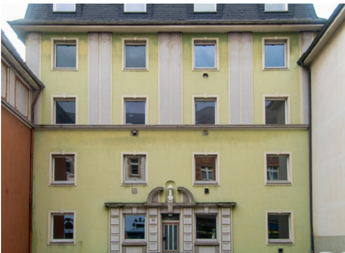
Frontansicht des Hauses Sedanstraße 85 vor der Modernisierung
