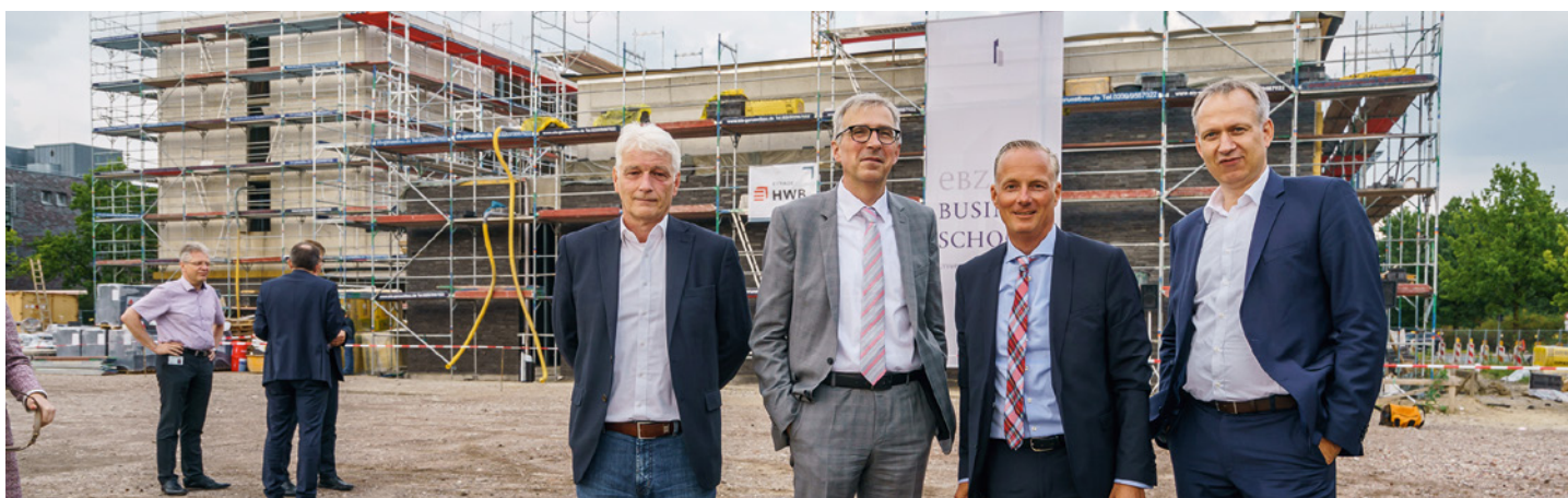
Richtfest für das neue Schulungs- und Ausbildungszentrum des EBZ
