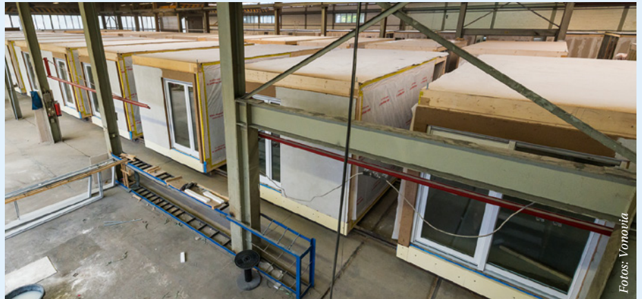
Wohnungen und einzelne Räume werden aus Holzmodulen gefertigt.
