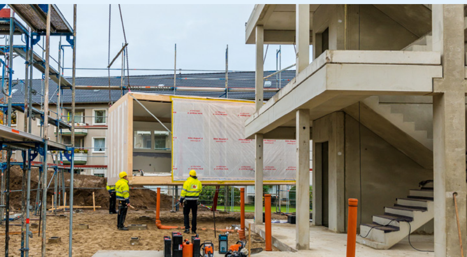
Vorgefertigte Bauteile verkürzen die Bauzeit.
