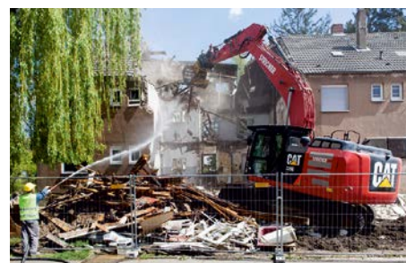
Abrissbeginn des ersten Bauabschnittes, Peter-Franzen-Straße, Ecke Gerhard-Bruders-Straße
