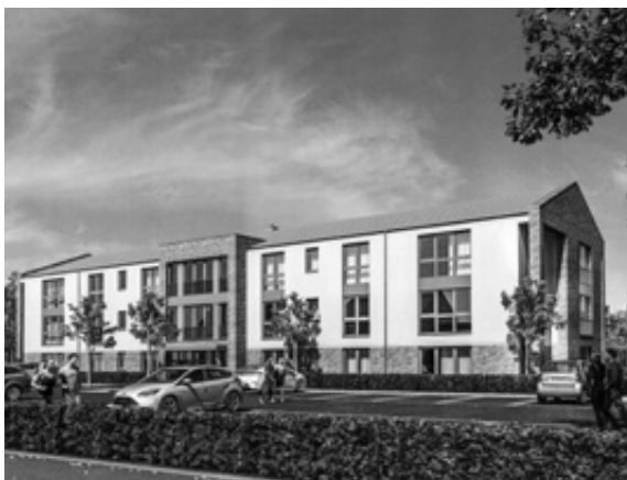
Strassenansicht Uerdinger Straße, Lank-Latum
