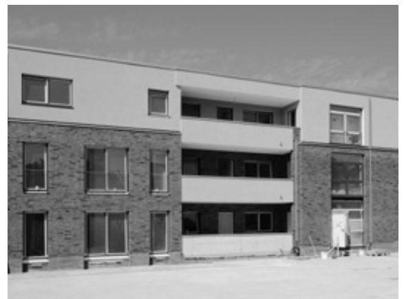
Heyerdrink 2. Bauabschnitt: Baustand April 2020
