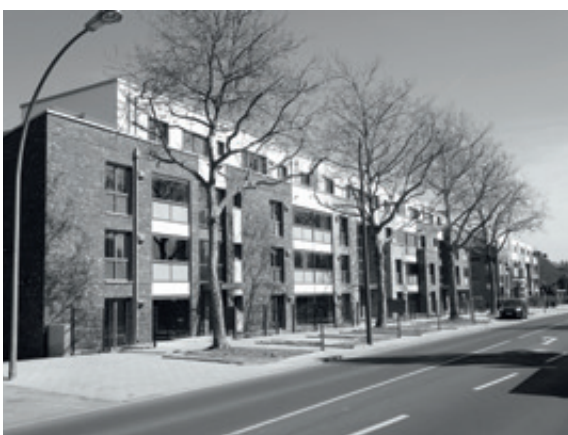
Moerser Straße in Büderich
