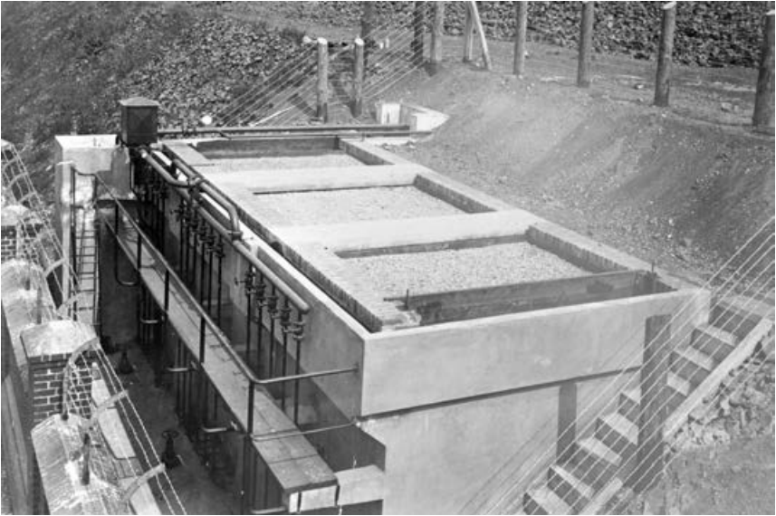
Abb. 102: Das „Emscherfilter“ zum biologischen Phenolabbau auf der Zeche Helene. Hermann Bach hatte das Verfahren 1924 zum Patent angemeldet.
