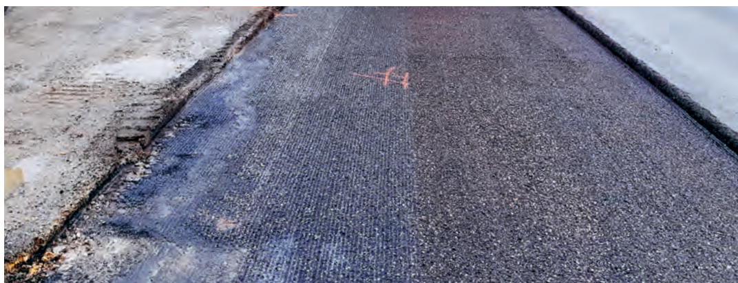
Gefräste und gereinigte Asphaltoberfläche
