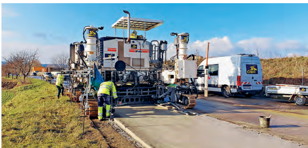
Halbseitiger White- Topping-Einbau mit Betondeckenfertiger
