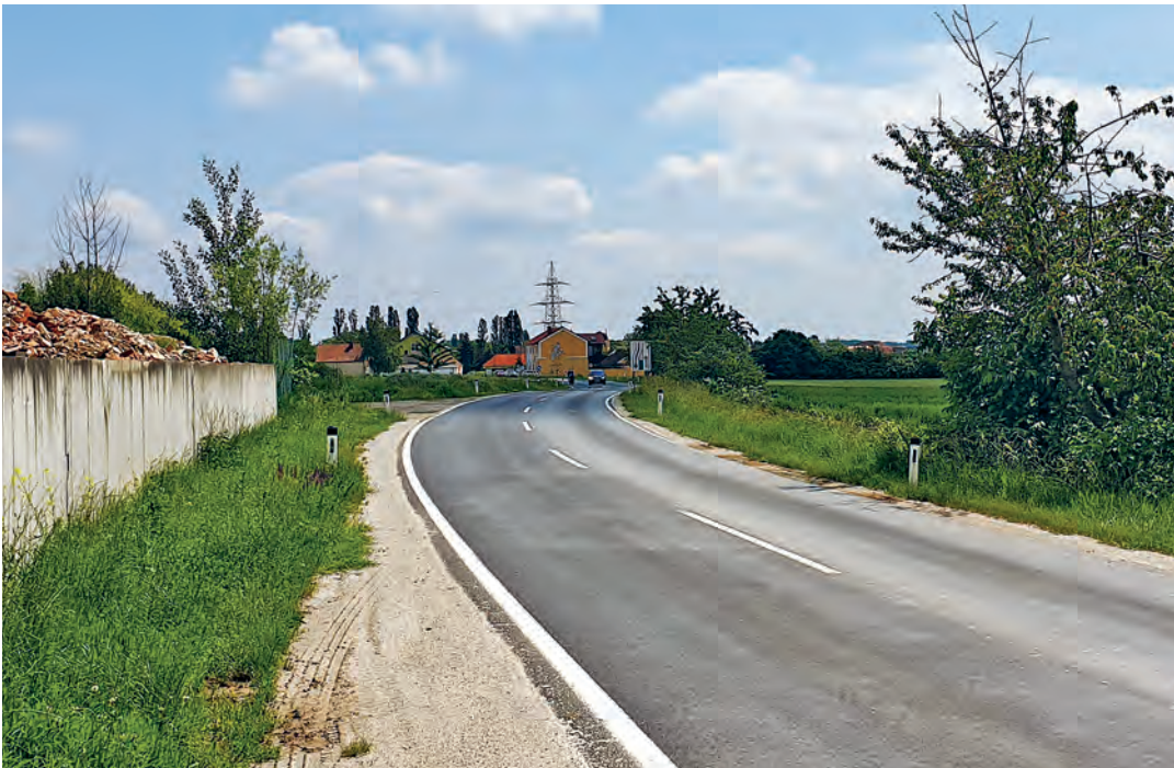
Der Streckenabschnitt vor der Baumaßnahme
