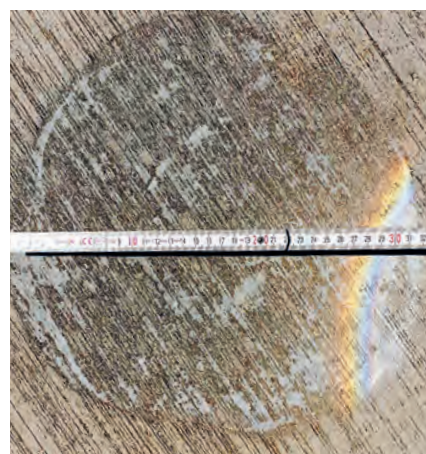
Oberbeton GK 22 mit Besenstrich
