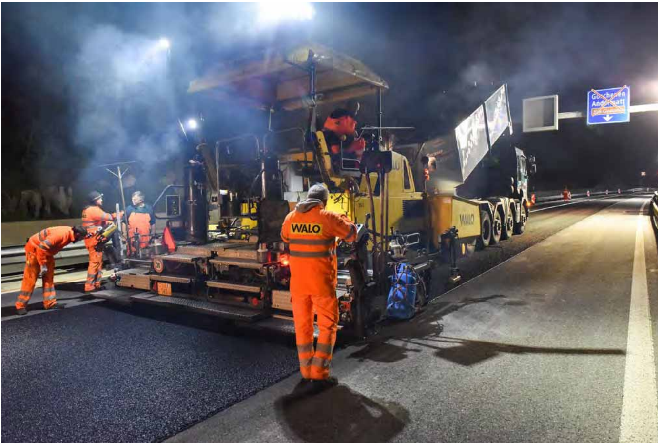
Deckbelagseinbau SDA 8-12
