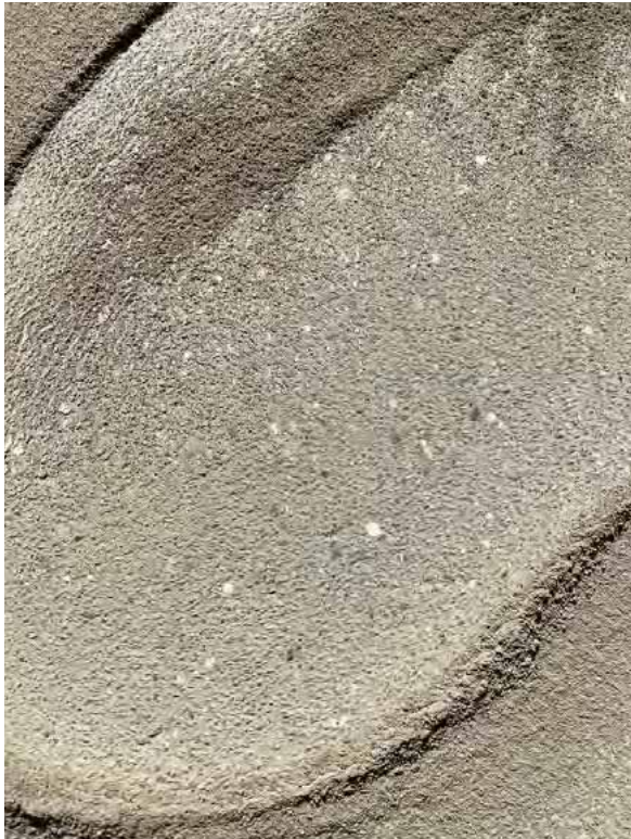
Betonoberfläche verzögert und Zementhaut entfernt (ausgebürstet)
