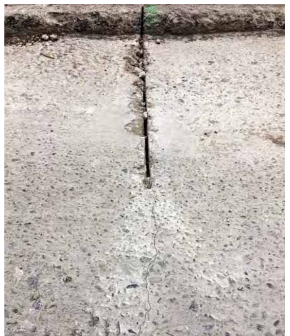
Active Crack Control und gleichmässige Rissverteilung alle 1,20 m–2,50 m / Rissbreiten 0,1 mm–0,5 mm
