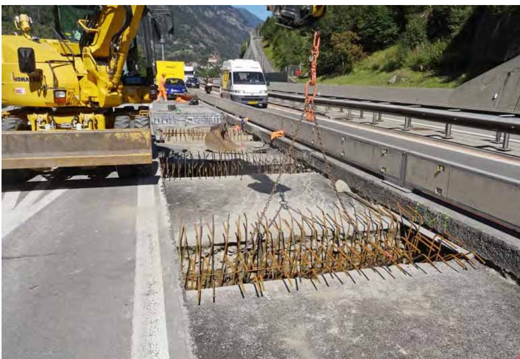
Bewehrung der Endverankerungen
