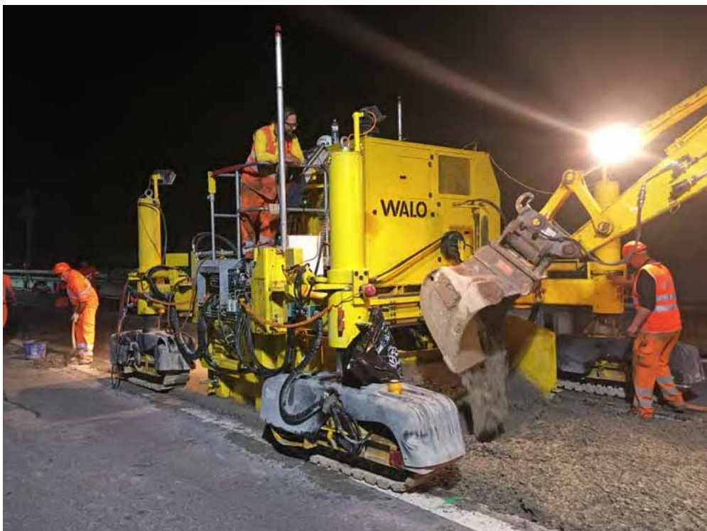
Maschineller Einbau mit Gleitschalungsfertiger
