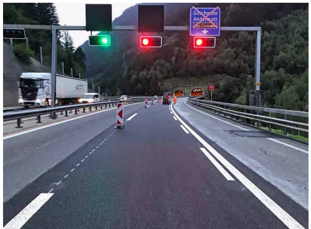
Bereit für die Verkehrsfreigabe (Blick Fahrtrichtung Süden)
