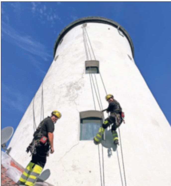
Hier wird alles für den Anstrich der Mühle vorbereitet. Bis zu fünf Tage wird dieser dauern. Foto: Julia Schäfer
