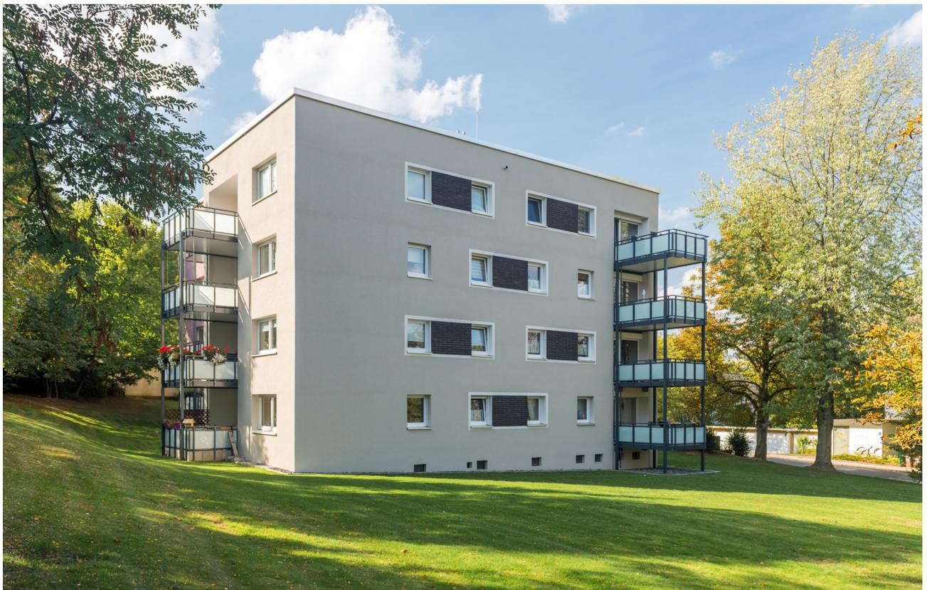
Nach der energetischen Modernisierung strahlen die Häuser in der Spillheide wieder. Die Fassade erhielt eine Wärmedämmung, Dächer und Fenster wurden erneuert und die Balkone erweitert.
