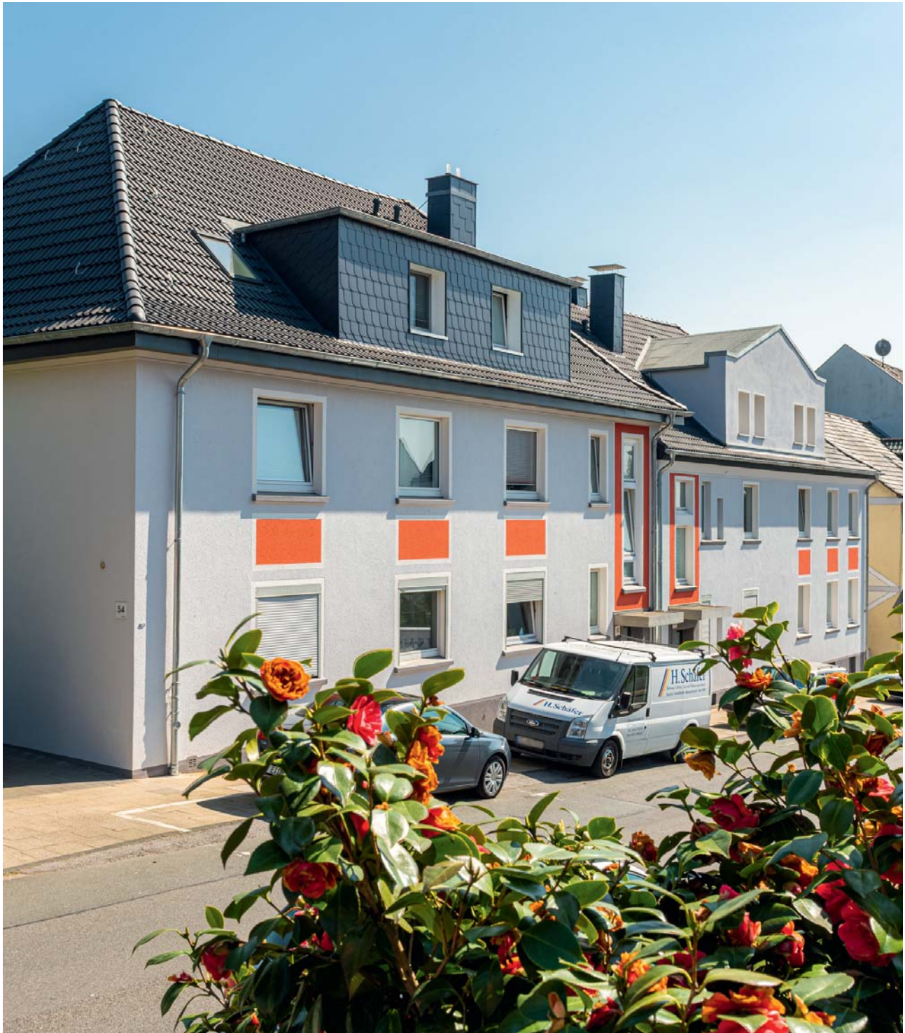
Die vier Häuser Steeler Bergstraße 48–54 erhielten einen neuen Fassadenanstrich, die Wohnungen wurden modernisiert und die Dächer wärmegeklämt.
